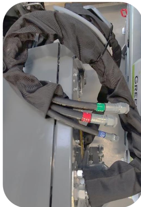
Tuyaux hydrauliques (pression, retour et vidange) sur l'épareuse Scorpion 3-430
